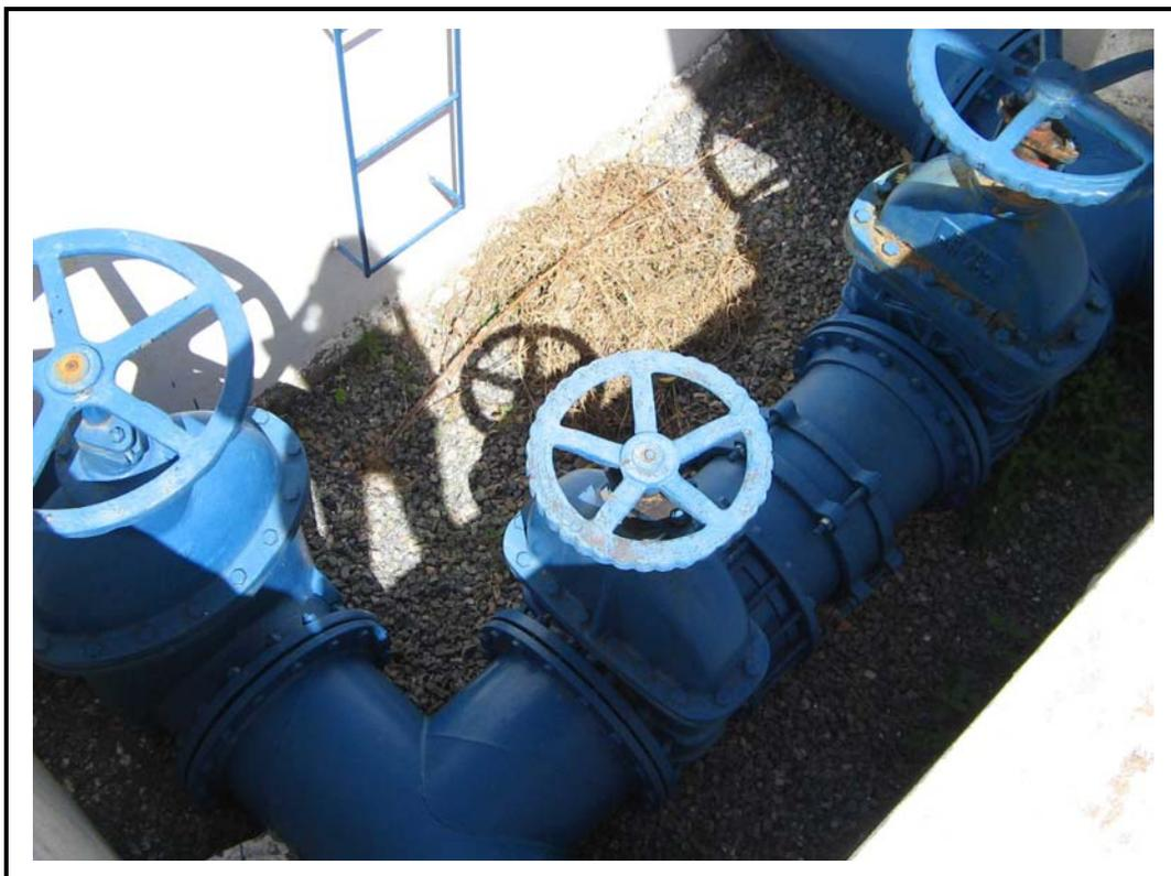
**Foto 09** - Tubulação e válvulas do barrilete de sucção da EE-2.
