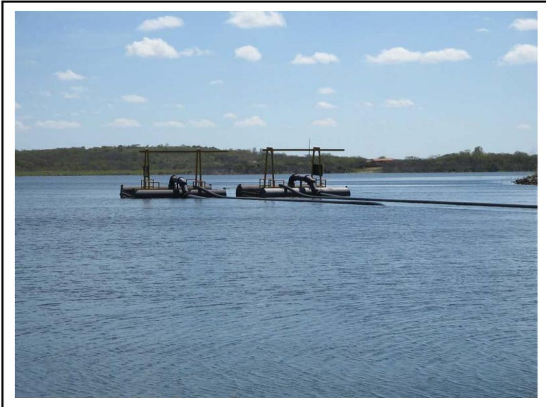
**Foto 01** - Captação flutuante em 02 módulos independentes e 02 tubulações de PEAD independentes.
