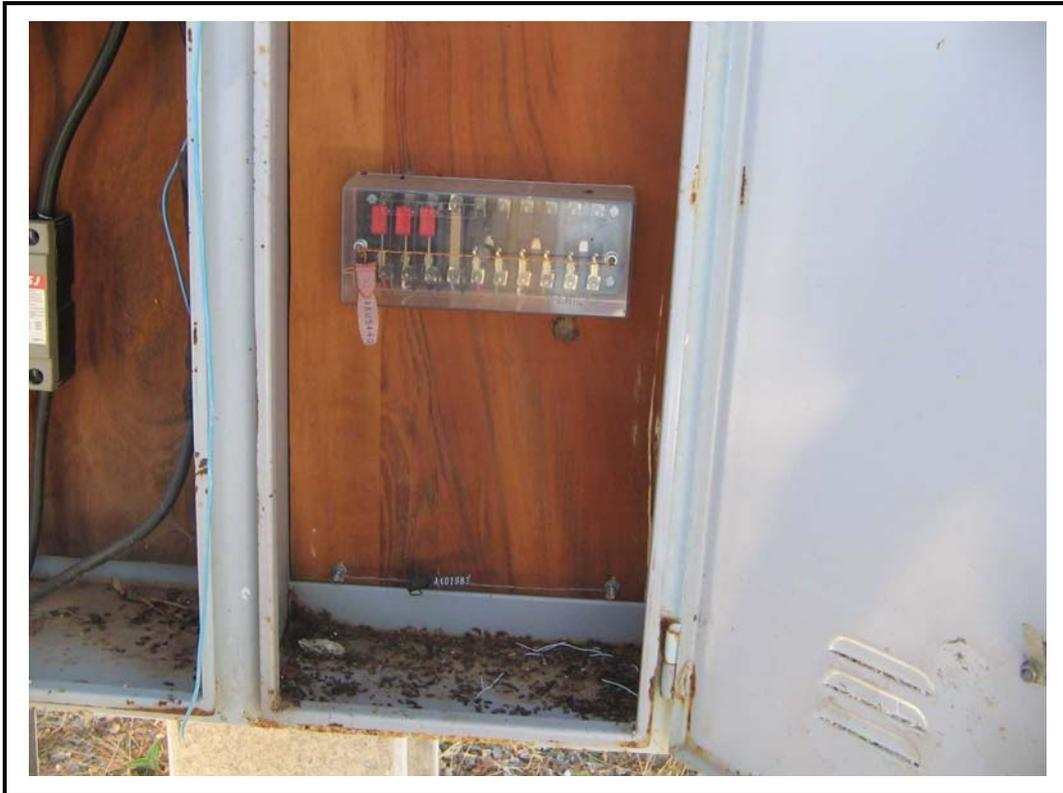
**Foto 07** - Painel de comando das bombas, podendo observar-se a ausência da borracha de vedação da porta e tela na veneziana, além de corrosão na dobradiça.
