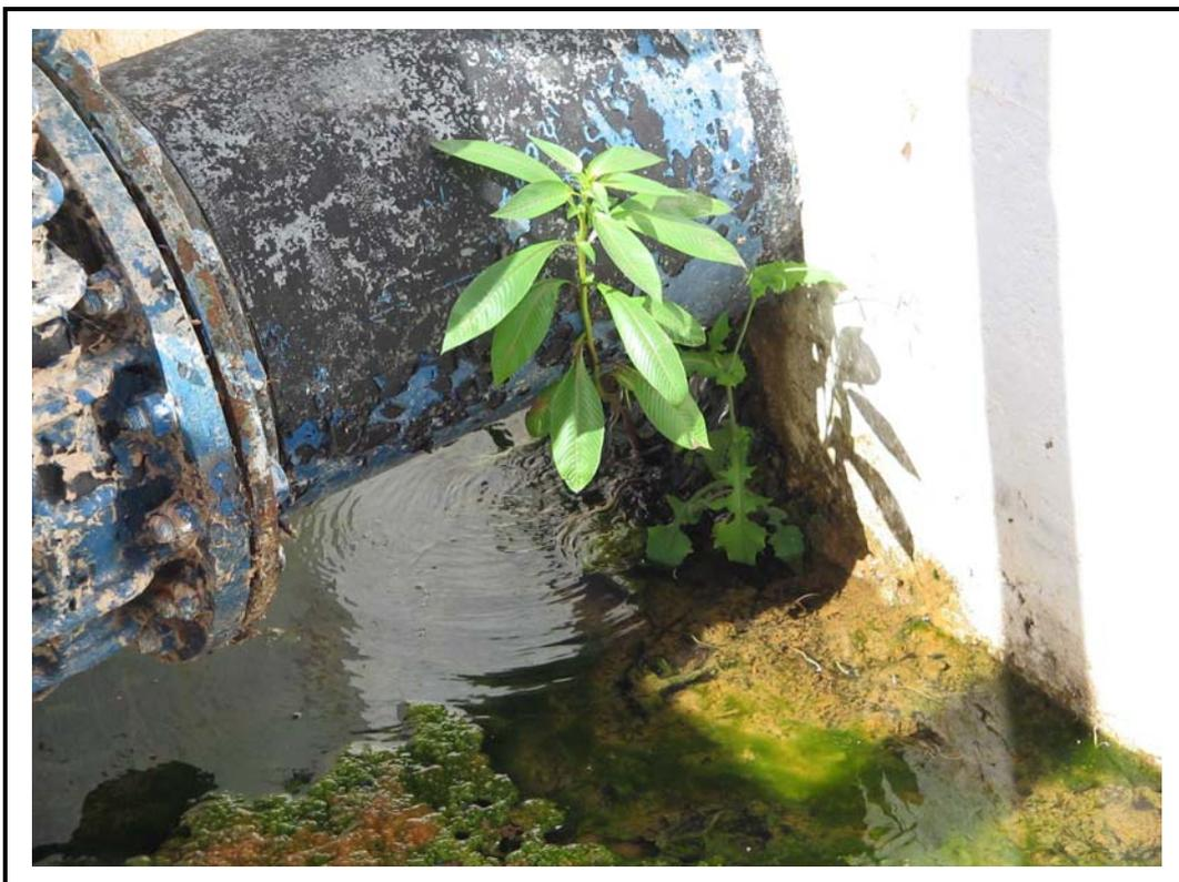
**Foto 03** - Caixa de chegada e reunião de água bruta, observando-se vazamento de origem não identificada.
