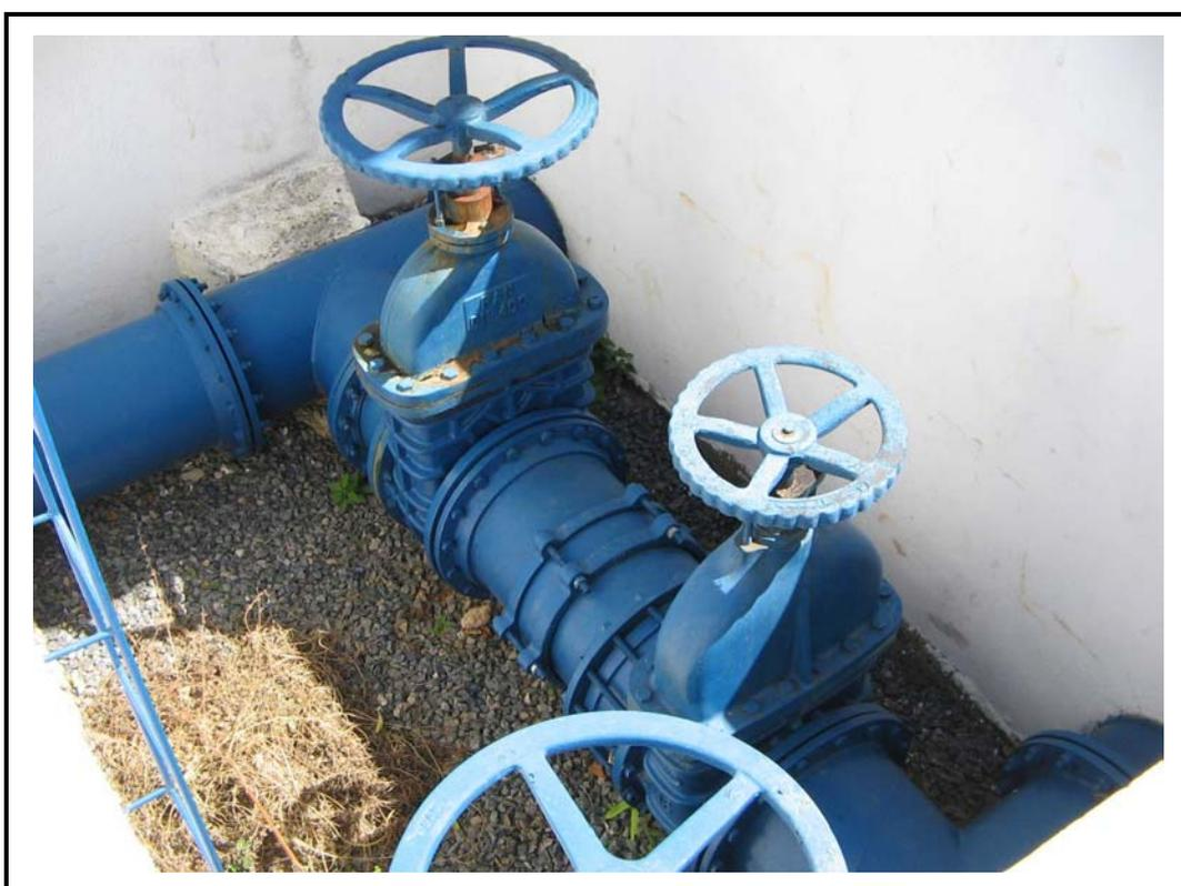
**Foto 10** - Tubulação e válvulas do barrilete de sucção da EE-2.
