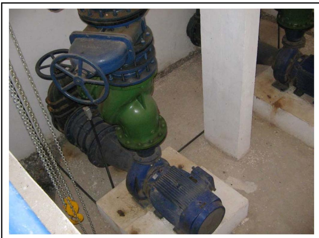
**Foto 11A** - Conjunto motor-bombas da EE-2, vendo-se a válvula de controle de pressão BERMAD (verde).
