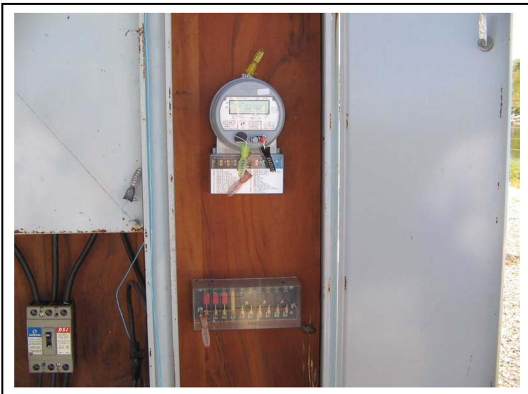
**Foto 08** - Painel de medição (externo) com mesmos problemas e maior incidência de corrosão.
