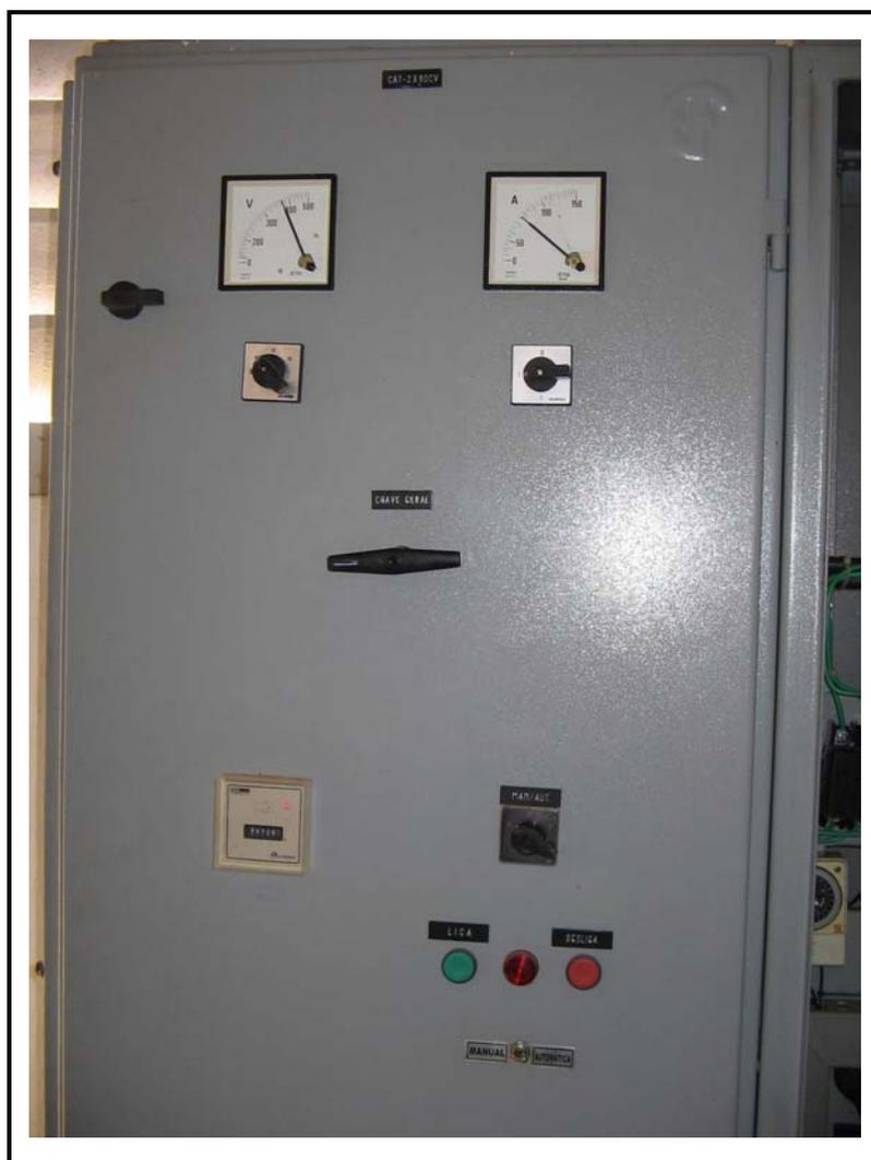
**Foto 25** - Painel de comando das bombas da EE-2.
