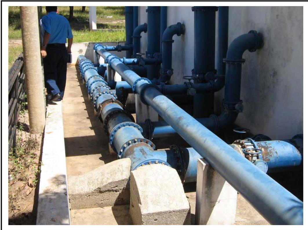
**Foto 19** - Tubulação de coleta de água filtrada e tubulação de lavagem dos filtros.
