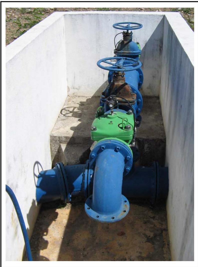
**Foto 23** - Saída da adutora de água bruta, vendo-se a válvula de controle de sobrepressão (anti-golpe de ariete).
