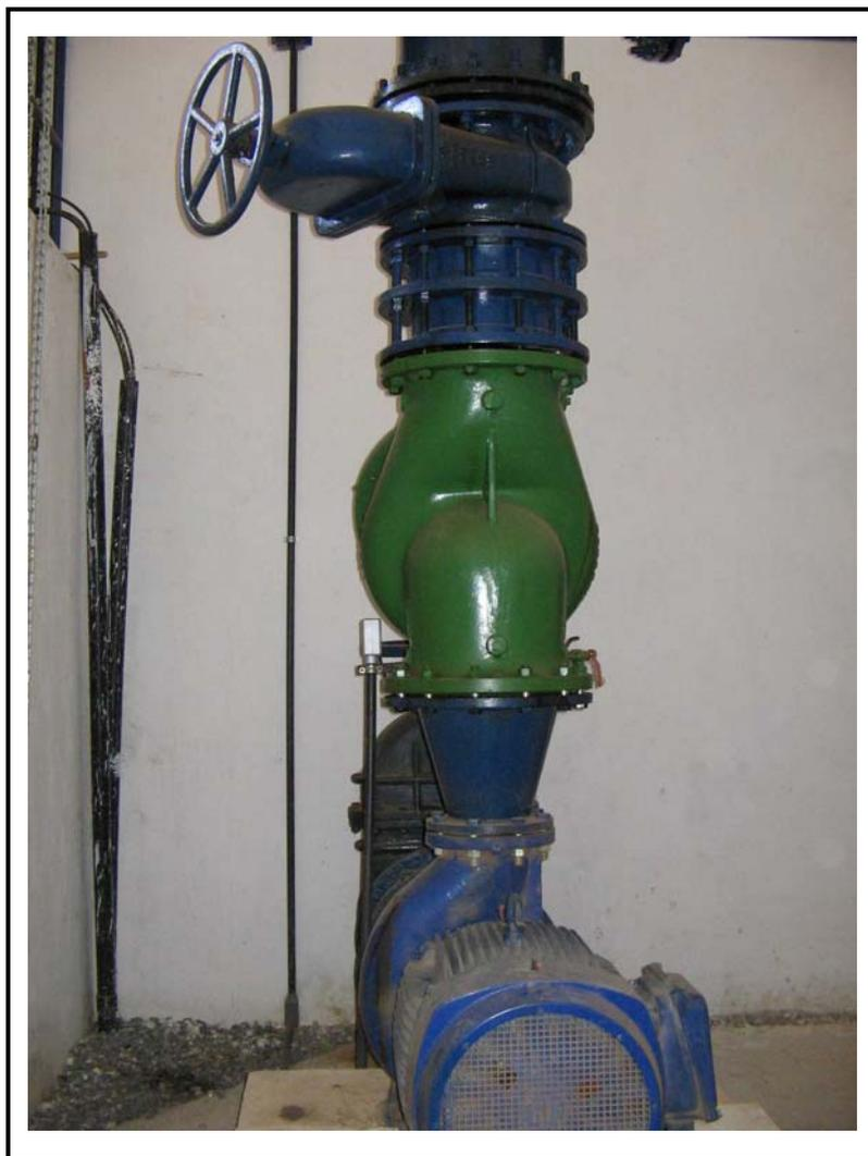
**Foto 14** - Conjunto motor-bomba, destacando-se a válvula BERMAD.
