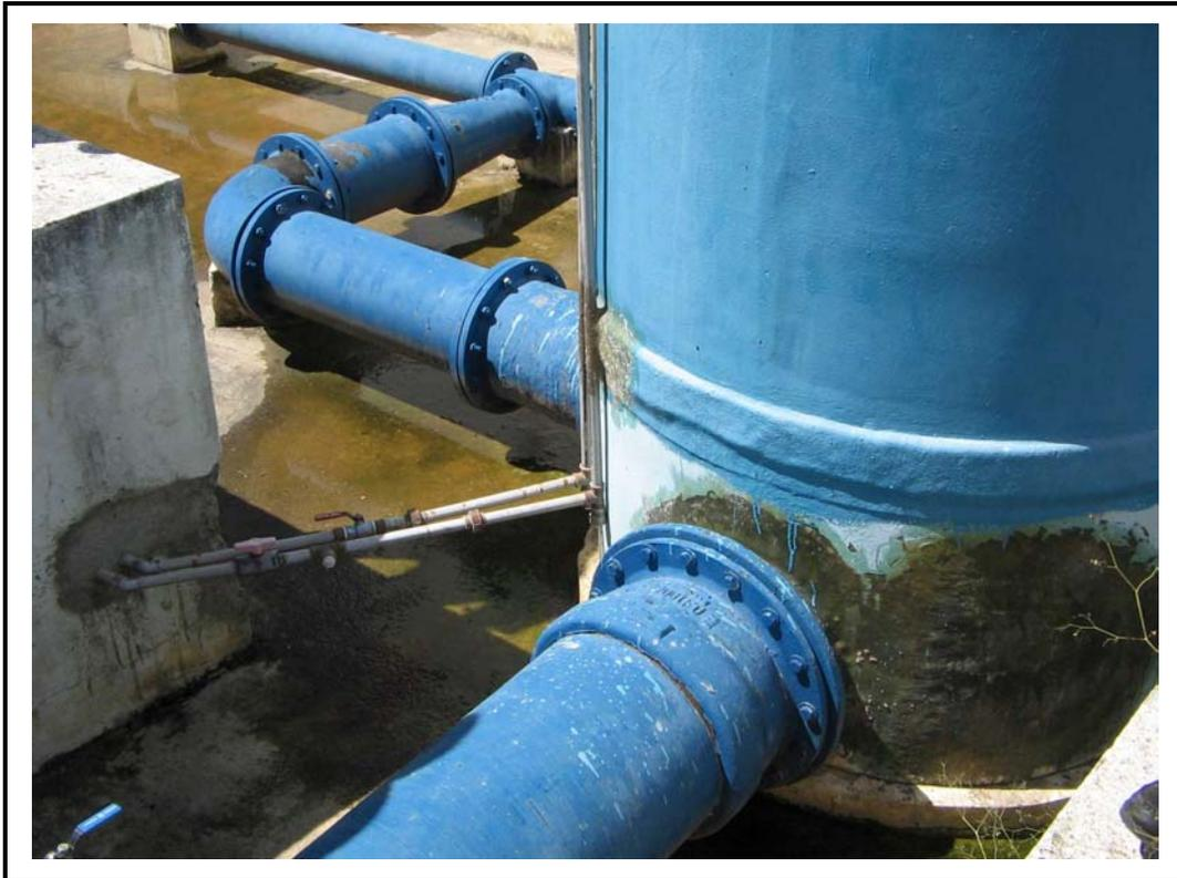
**Foto 17** - Câmara de carga e distribuição para os filtros.
