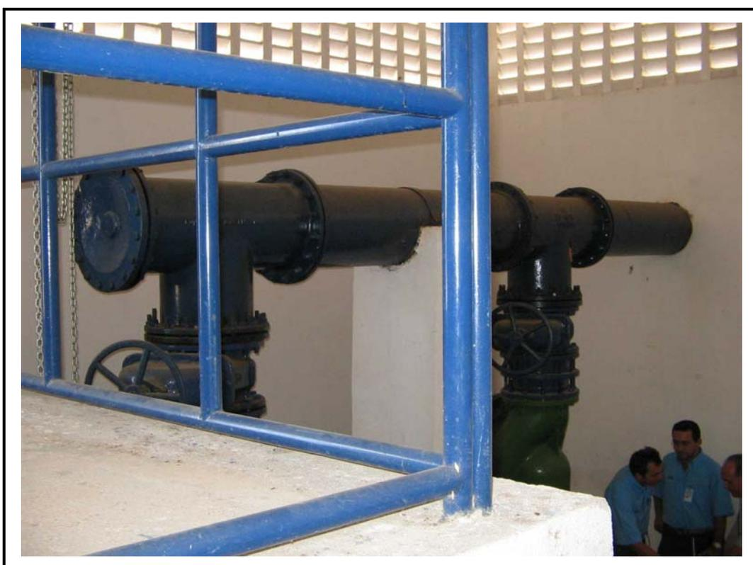
**Foto 13** - Barrilete de recalque da EE-2.
